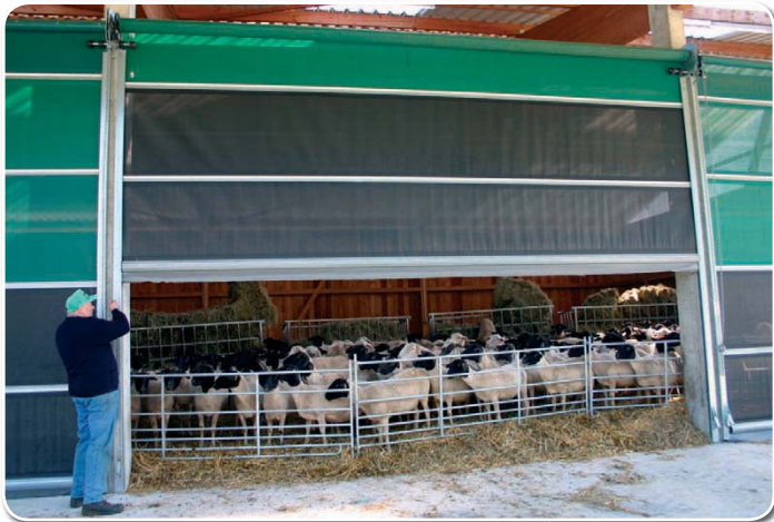
Agrartore mit Kettenantrieb zum leichten und schnellen Verschließen bzw. Öffnen von Toren
