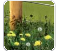
starker Bewuchs – der Zaundraht verläuft komplett im Bewuchs
